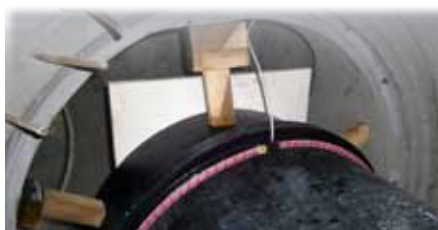
T-stykke med påmontert injeksjons- og mateslange
