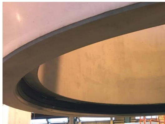
Innstøpt gummipakning
