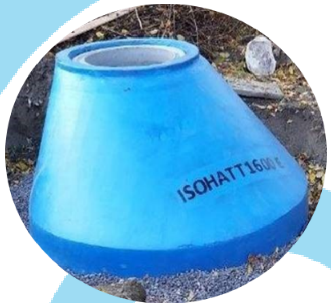
ISOHATT™ 1600 eksentrisk montert på betongkum klar for tildekking
