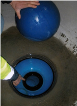
Visuell inspeksjon av nedre pakning
