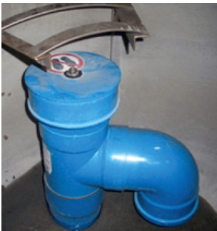
Visuell inspeksjon - flottøren
